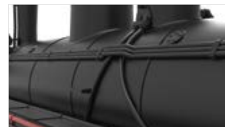
Extra angesetzte Kesselleitungen
