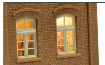
8. Dieses Bild zeigt die bessere Wirkung des mit Laibung versehenen Fensters (links). Picture shows the better method using embasure (left window).
